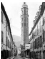
La Tour des Jacobins à Bagnères de Bigorre dans les Hautes-Pyrénées : y a-t-il une ou plusieurs causes à la dérive de verticalité ? Est-ce le résultat de tassements différentiels de surface, de l'exploitation des eaux minérales à 50°C sulfatées calciques et magnésiennes, de l'activité sismique ou de l'incendie de 1343 ?
