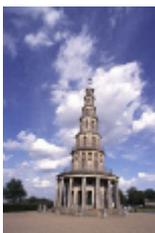
La Pagode de Chanteloup, en Indre-et-Loire, où les méfaits de la suppression d'un plan d'eau ont conduit au pourrissement des pieux de fondation en bois et à l'inclinaison de l'ouvrage.
